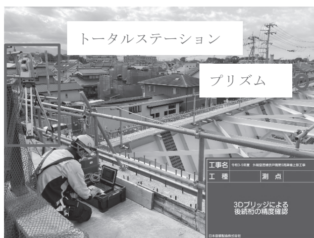
図-4 3Dブリッジによる計測状況
