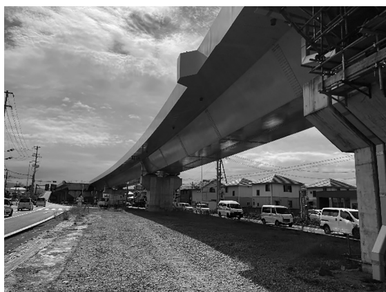
図-1 余戸南第5高架橋 全景
