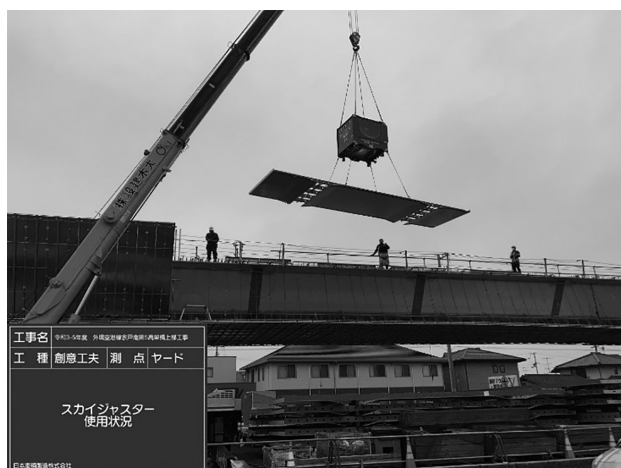
図-7 スカイジャスターを使用した鋼板パネル架設状況
