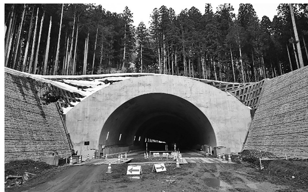
図-1 坑口部全景（竣工時）
