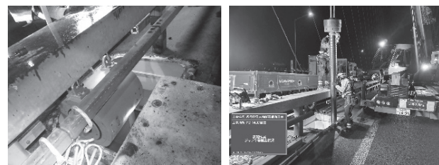
(a) ジャッキ本体取込 (b) 3m テンションロッド
