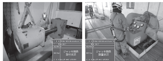
(c) 張力解放設備の設置 (d) 電動ポンプ操作
