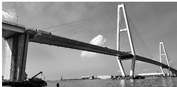
図-1 名港中央大橋全景
