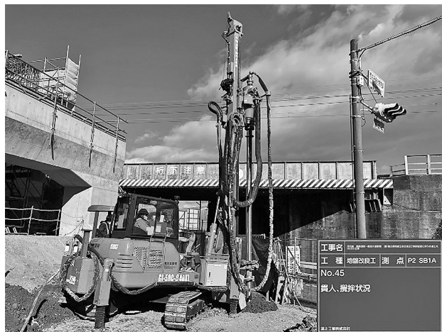
図-7 スラリー攪拌工法施工状況
