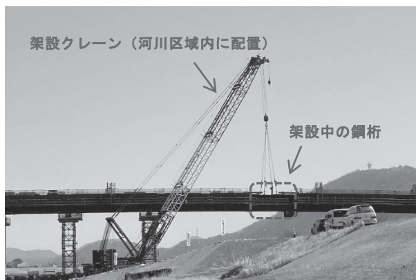
図-5 河川区域内からの架設状況
