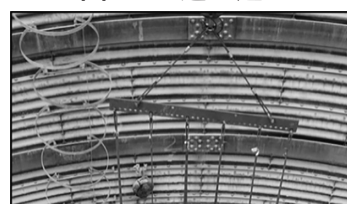
図-9 専用吊り具
