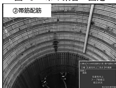
図-6 帯筋配筋
