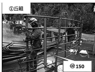
図-4 専用吊り架台丘組
