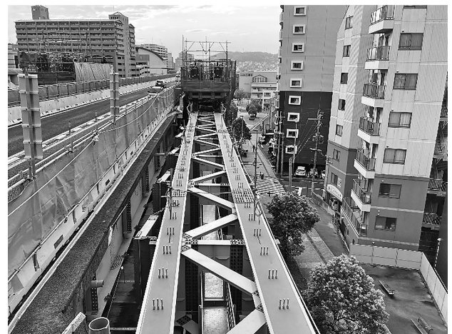
図-10 吊上げ架設完了
