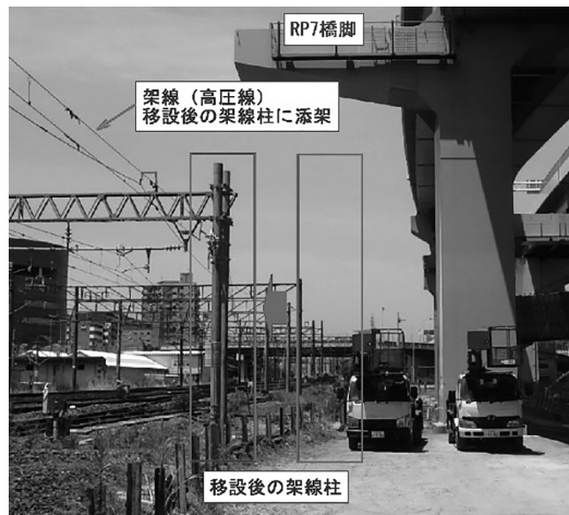
図-3 移設前後の架線柱
