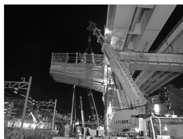
図-9 新設橋脚梁の架設状況
