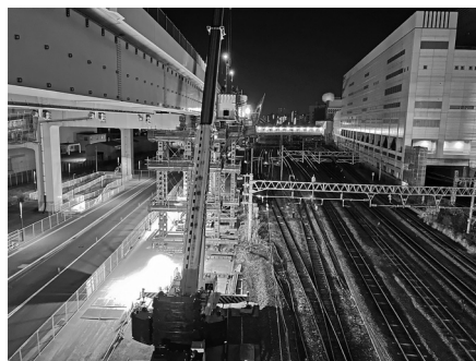
図-12 主桁の架設状況
