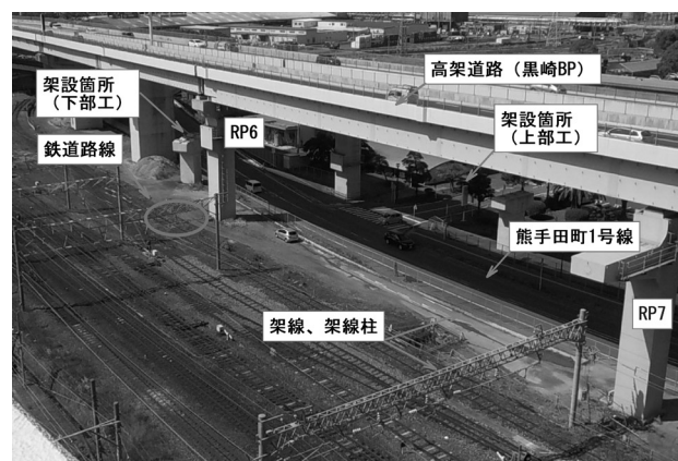
図-1 施工ヤード状況
