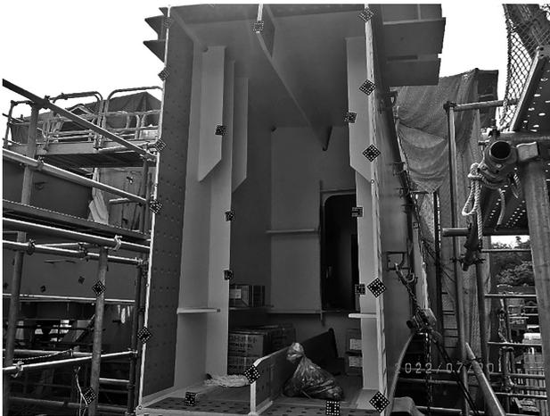
図-8 PIXXISによる3D計測（ターゲット）
