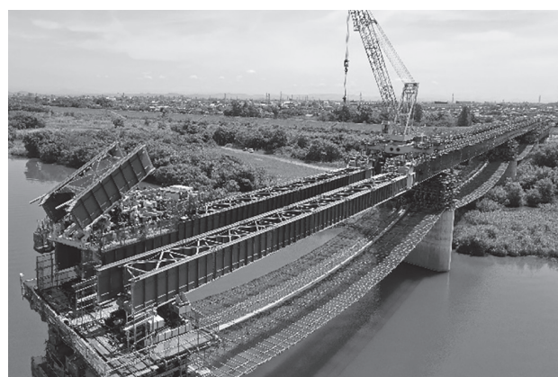
図-10 手延機解体状況
