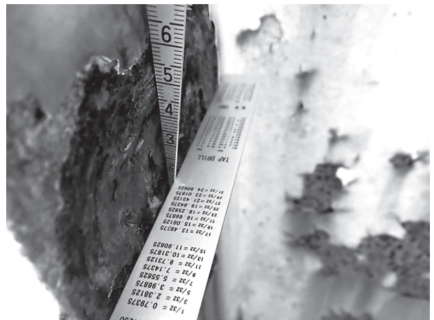
図-3 腐食調査状況
