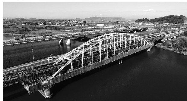
図-1 旧天王橋ランガー桁
