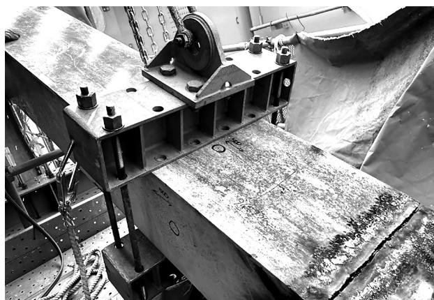
図-9 歩道橋の吊金具設置状況
