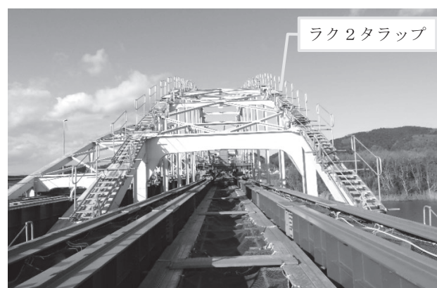
図-7 ラク2トラップ設置状況
