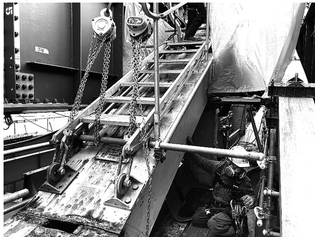
図-8 車道橋の吊金具設置状況
