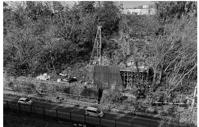
図-6 大口径ボーリングマシン施工図
