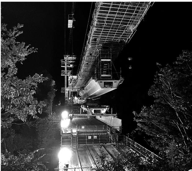
図-5 補剛桁架設状況図
