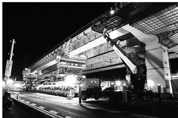
図-10 多軸台車による中央径間架設
