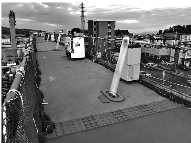
図-9 日照で高温となった架設前の桁を冷却
