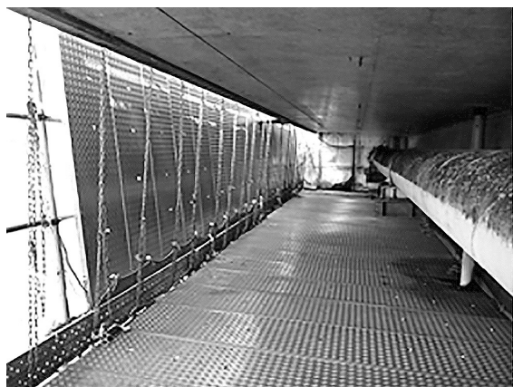
図-2 足場組立全景 (SKパネルによる養生)
