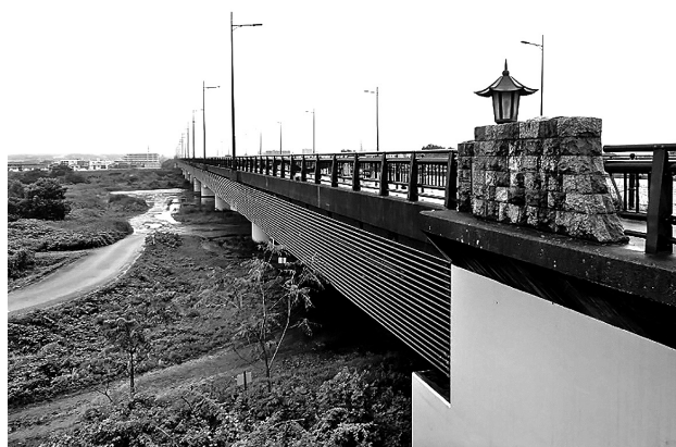
図-1 現場施工前状況
