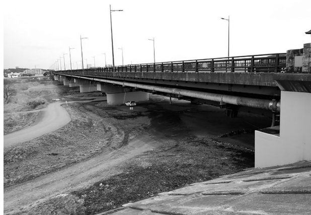
図-4 現場施工完了全景
