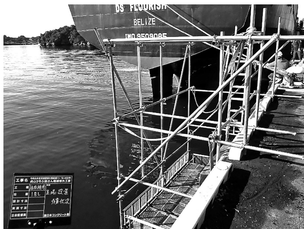
図-3 簡易足場設置状況
