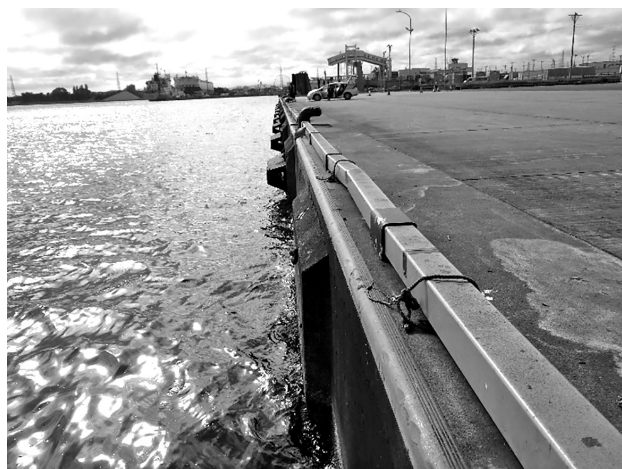
図-1 現場施工前状況
