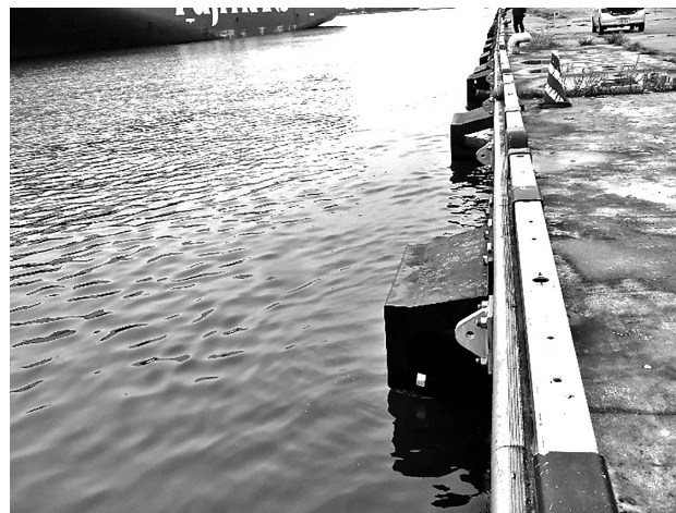
図-4 防舷材設置完了
