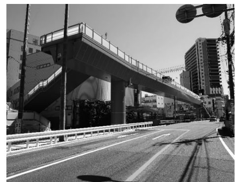
図-1 桜町横断歩道橋全景
