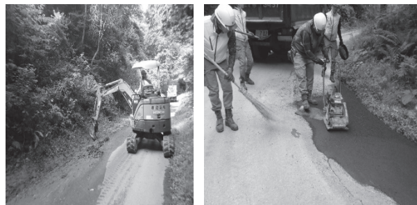
図-5 側溝土砂撤去・路肩補修
