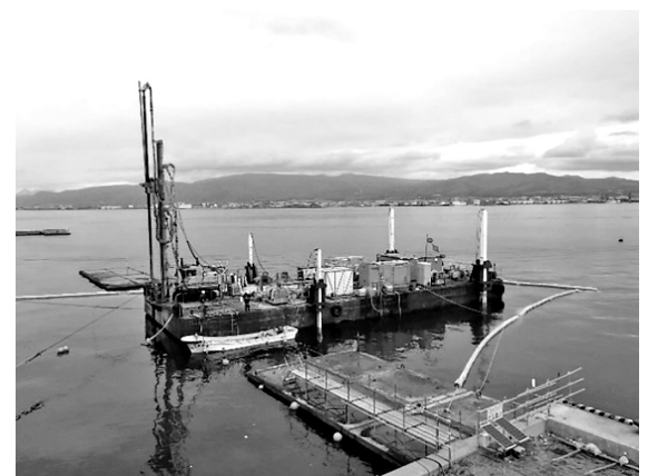
図-3 海上地盤改良状況
