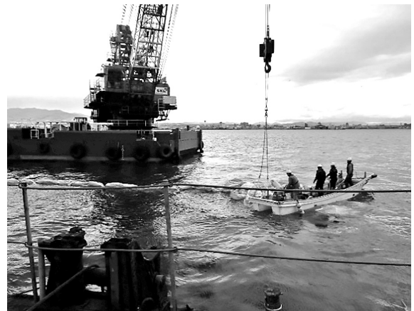
図-2 汚濁防止膜の設置状況
