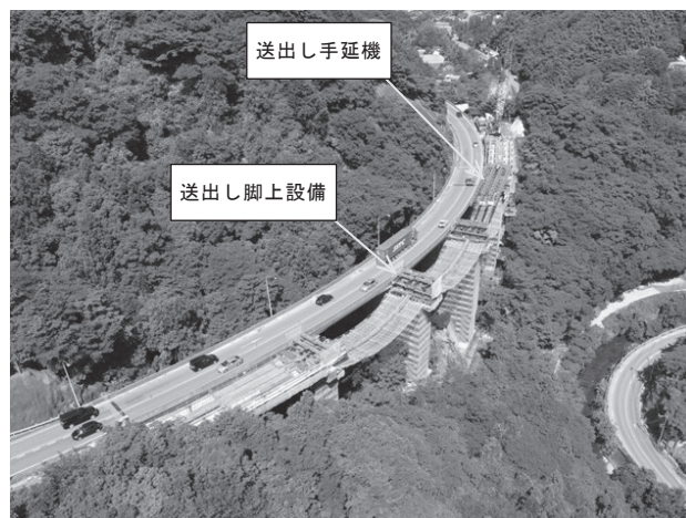
図-5 送出し架設状況
