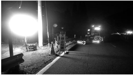
図-2 夜間通行規制状況
