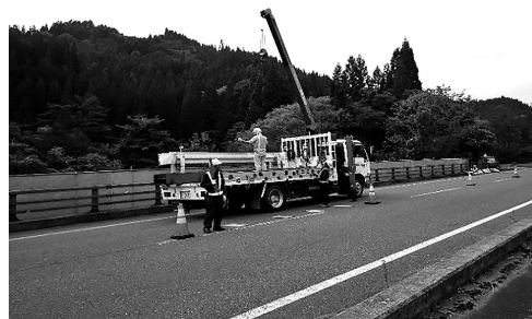
図-1 H鋼付ガードレール設置
