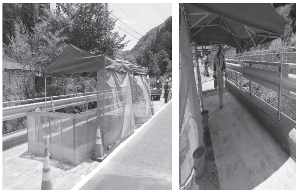
図-4 簡易テント設置 湿潤養生
