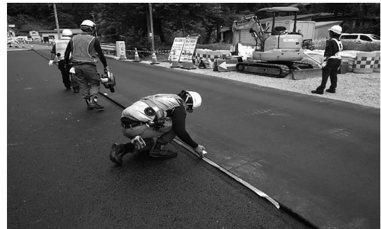
図-5 舗装打ち継ぎ目 成形目地設置
