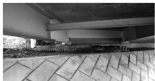
図-6 排水管流末処理
