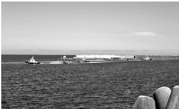
図-3 海上運搬状況
