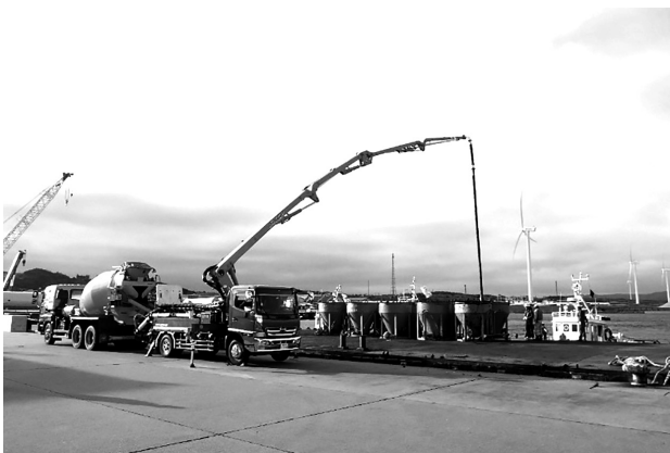
図-2 生コンクリート荷卸し状況
