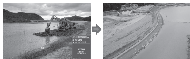
図-1 工事用道路の嵩上げ
