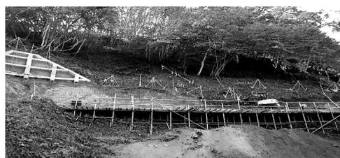
図-8 第1仮設構台上で2回目の土工
