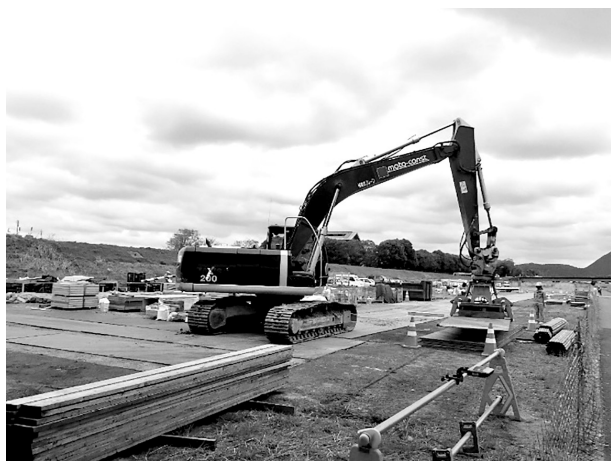
図-2 敷鉄板マグネット付バックホウ使用状況
