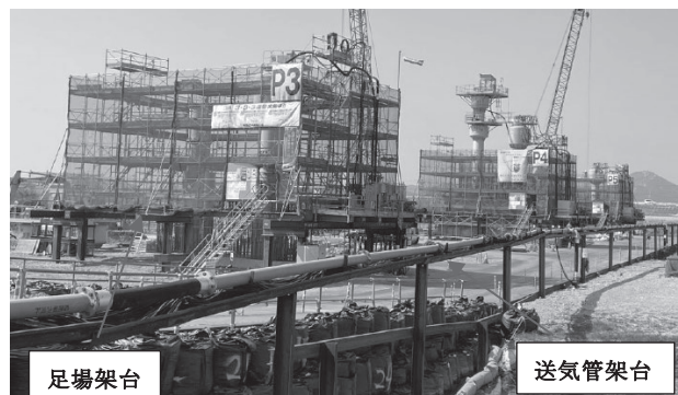
図-2-2 現場施工状況 (足場・送気管架台 FH=7.200m)
