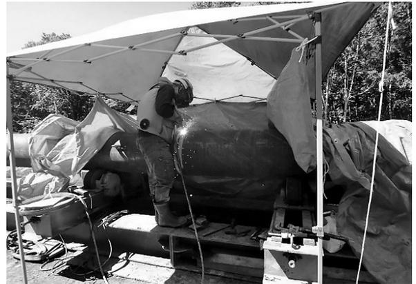
図-5 防風小屋覆いでの溶接作業状況
