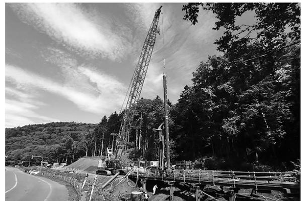
図-6 現場溶接後鋼管杭建込み状況
