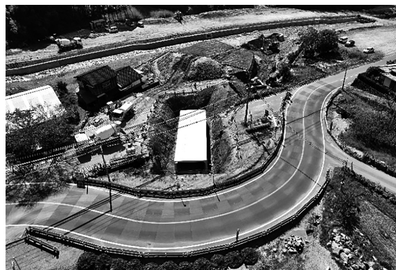
図-2 函渠工 施工状況
