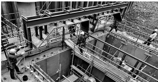
図-4 プレキャスト型枠（スラブ）設置状況
