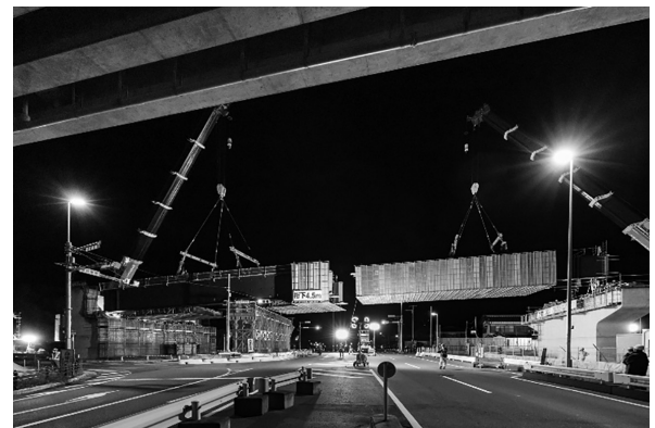
図-4 国道408号上架設状況
