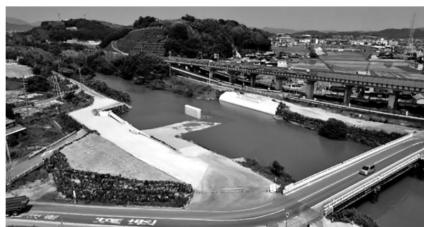
図-6 工事完了全景
