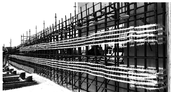
図-5 橋台コンクリートひびわれ対策
