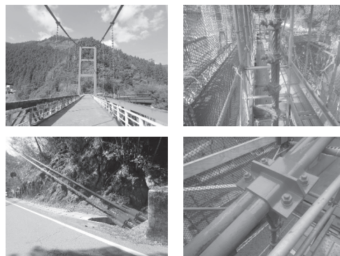
図-3 施工完了写真
