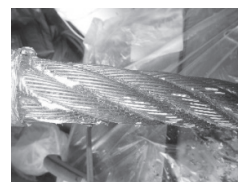
図-7 塗装剥離完了後
