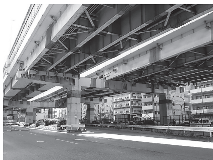
図-1 首都高速道路9号深川線
