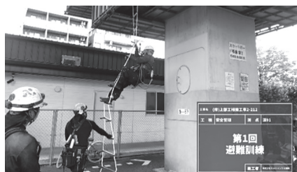
図-4 縄梯子による避難設備
