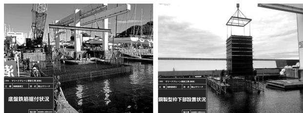
図-4 大組鉄筋据付状況 図-5 埋設型枠据付状況
