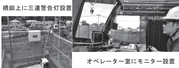
図-2 3Dバリア設置状況
