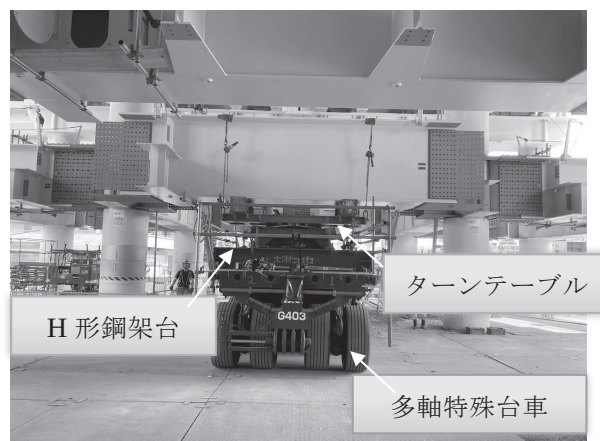
図-3 中階横桁の架設状況
