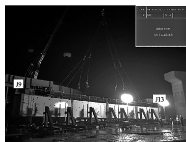
図-4 試験吊り状況
