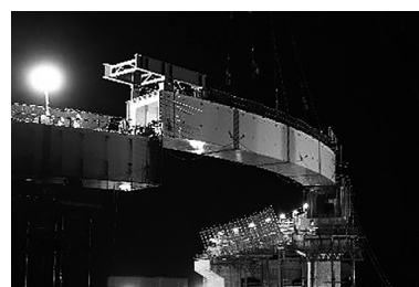
図-6 大ブロック落とし込み架設状況
