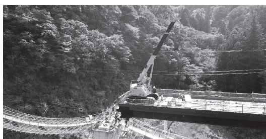
図-4 桁先端でのクレーン作業状況
