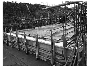
図-4 断熱養生状況
