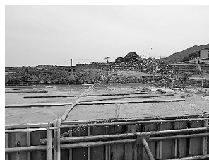
図-3 散水養生状況
