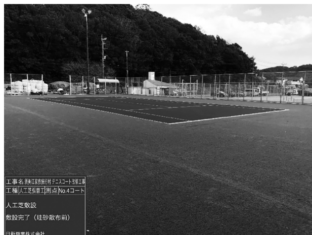
図-3 人工芝敷設完了（珪砂散布前）
