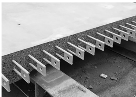
図-1 孔明き鋼板継手
