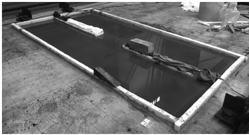
図-10 水張試験実施状況
