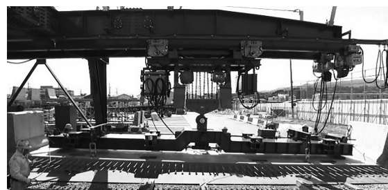
図-7 新設床版架設時の天秤構造
