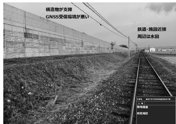
図-2 着工前状況
