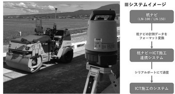
図-3 杭ナビ転圧管理システム
