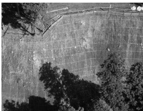
図-6 PPロープによる芯だし作業
