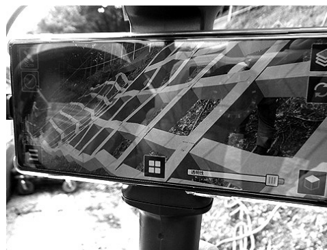
図-8 MR技術活用による芯出し作業
