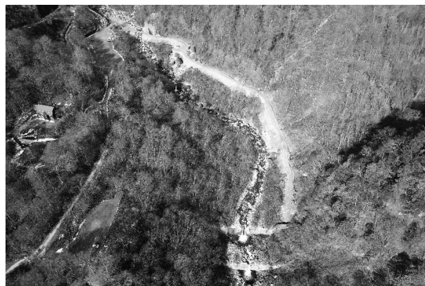
図-10 上流工事用道路全景
