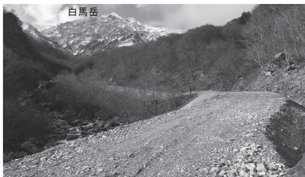
図-11 工事用道路（下流より上流を望む）
