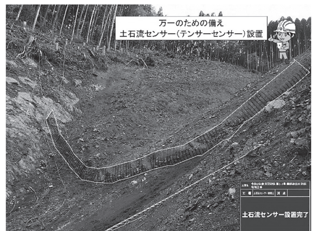
図-10 土石流センサー設置状況
