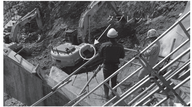
図-9 どこでもICT (左岸側)
