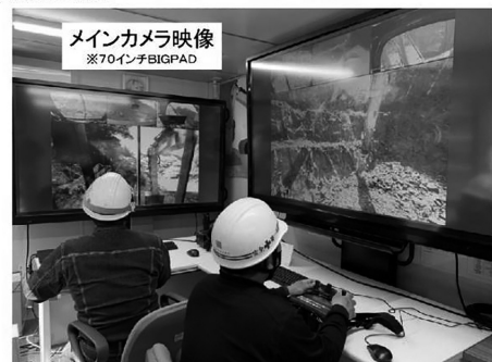
図-14 遠隔操作室での施工状況
