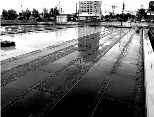
図-8 降雨時の床版面
