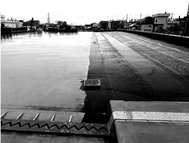
図-9 降雨後の床版面
