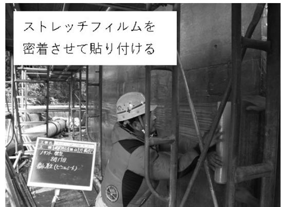
図-7 ストレッチフィルム巻付け状況
