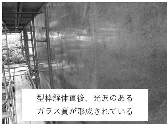
図-5 脱型直後のコンクリート表面
