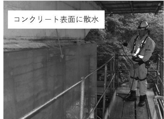
図-6 脱型後の散水状況
