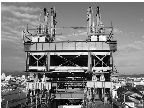
図-7 降下装置（ワイヤークランプジャッキ）
