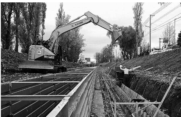
図-7 河川内作業状況
