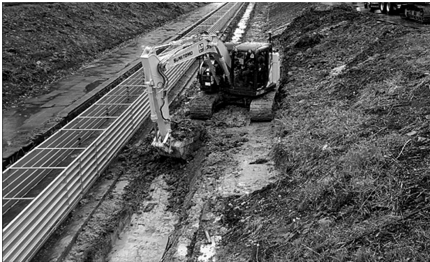
図-6 掘削作業状況
