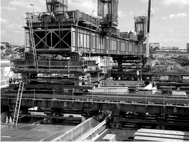
図-5 架設桁組立状況
